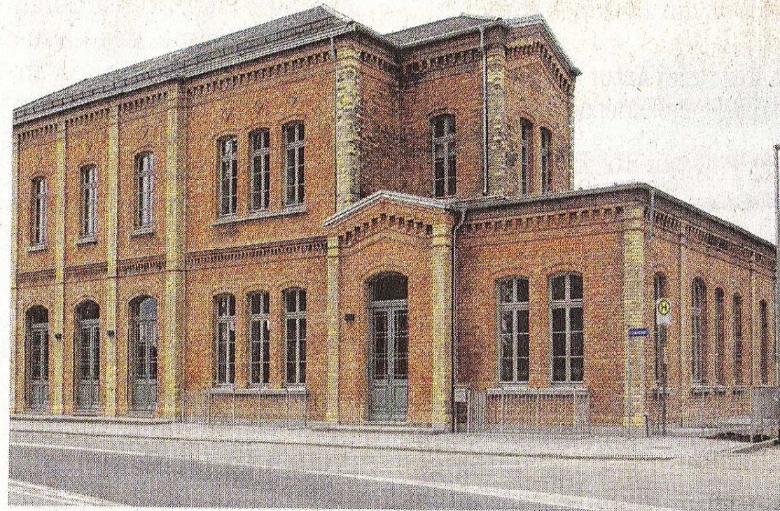
Mit der Sanierung erstrahlen die Fassaden des Bahnhofs in neuem Glanz.
